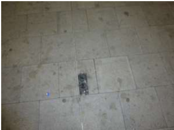
Foto 5377; gat dichten spoor 8.
