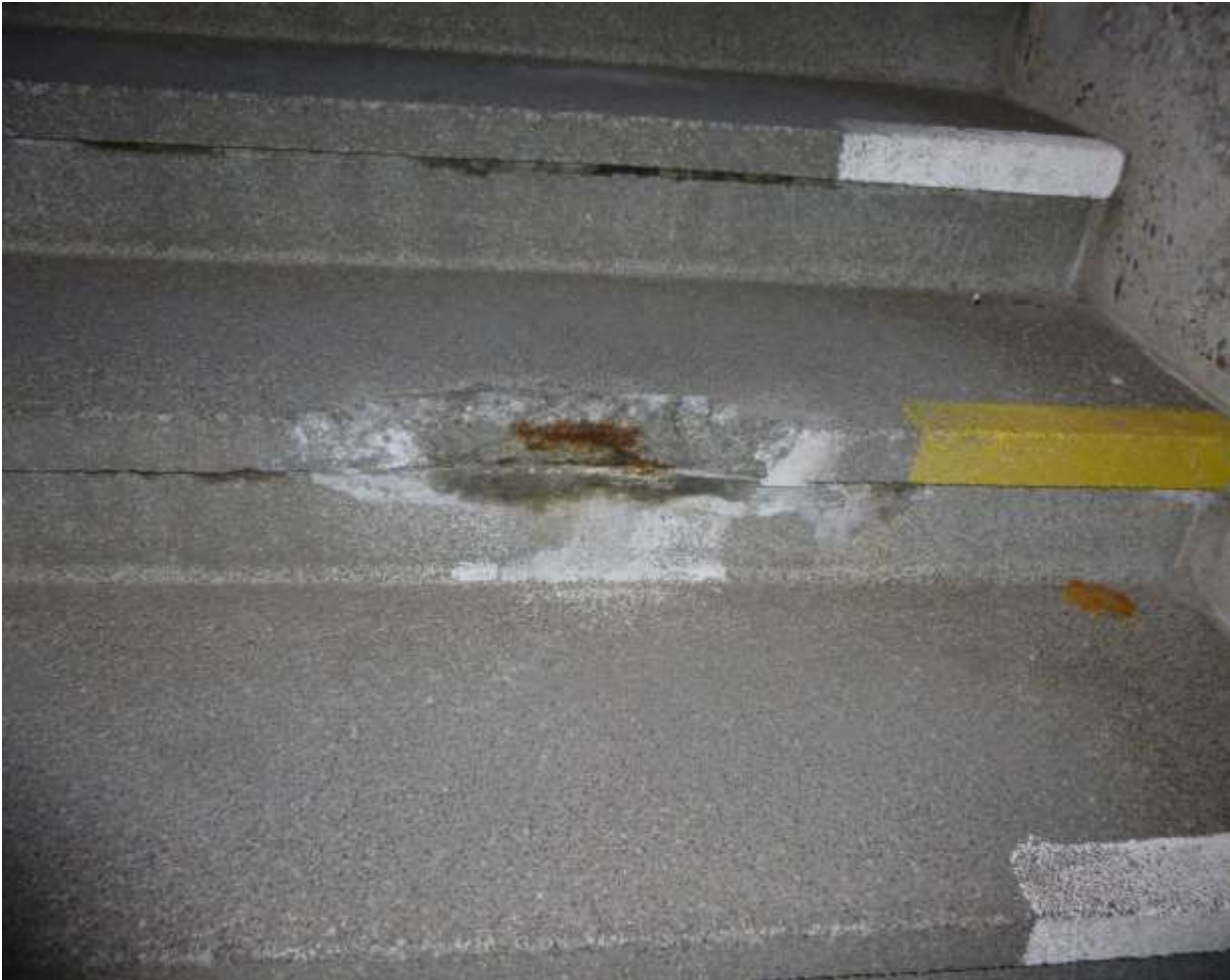
Foto 5383; trede herstellen spoor 2-3 ter hoogte van het Bernard viaduct.
