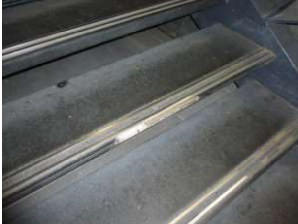
Foto 5375; trede repareren tram D-3-4.
